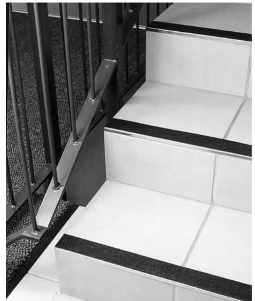
Figura 2: strisce antiscivolo applicate su scalini lisci.
