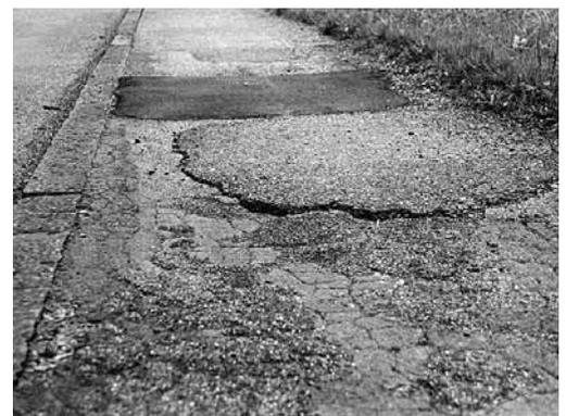
Figura 3: rivestimento riparato malamente; i dislivelli devono essere ridotti al minimo.
