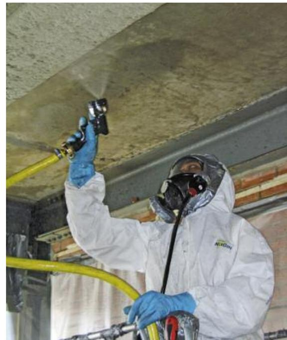
Abb. 4: Die Sanierung von Spritzasbest auf einer Asbest-Sanierungsbaustelle.
