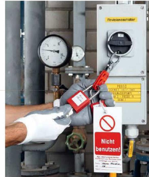
**Arbeitnehmer:** Bevor ich an der Anlage arbeite, schalte ich alle Energiequellen und Materialströme aus. Ich sichere die Anlage mit meinem persönlichen Vorhängeschloss.
