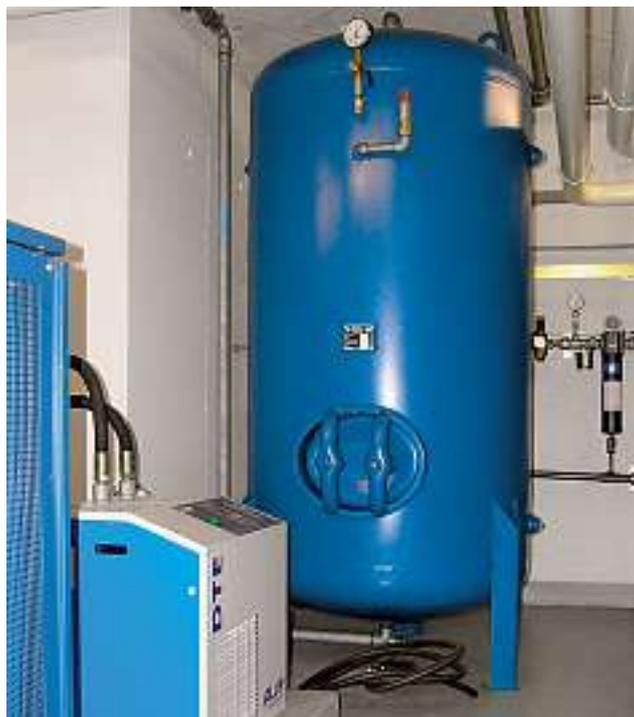
Druckluftbehälter mit Entfeuchter
