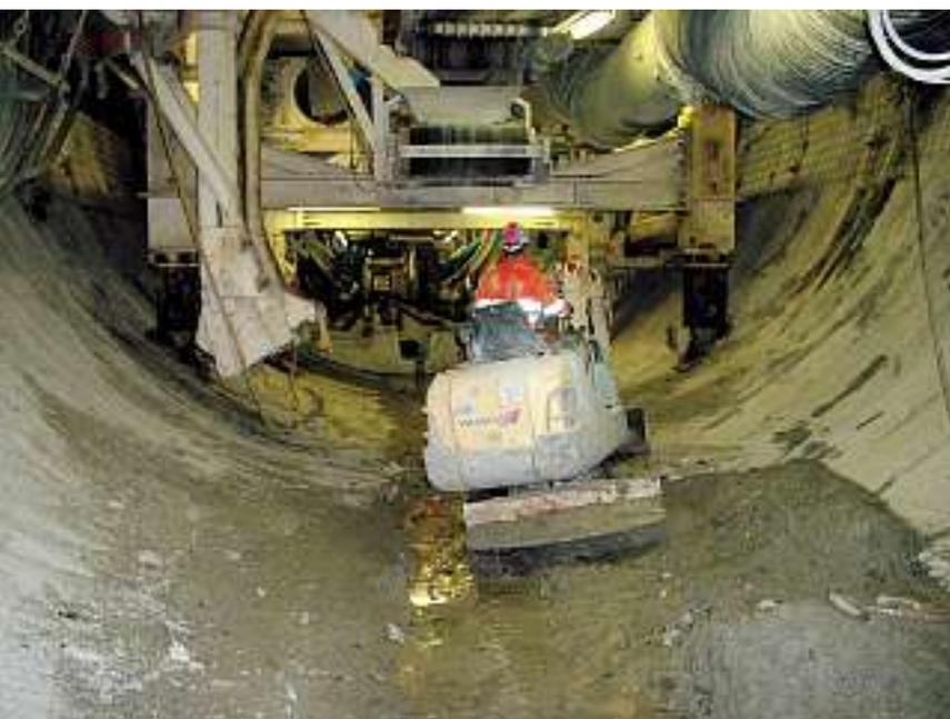
Abb. 3: Arbeiten im Vortriebsbereich unterhalb der Tunnelbohrmaschine
